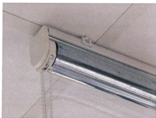
POSE DU PROFIL ARRIÈRE PAR CLIPS FAUX PLAFOND
